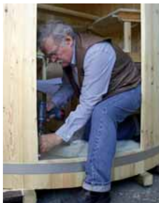
Nu ska kaminen sättas in. Det tar cirka en månad att göra en bastutunna för Timo.
